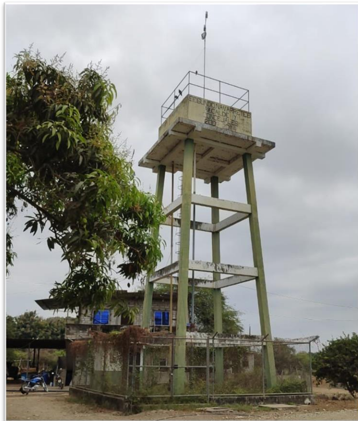
Imagen 46. Tanque elevado – Las Cañas
