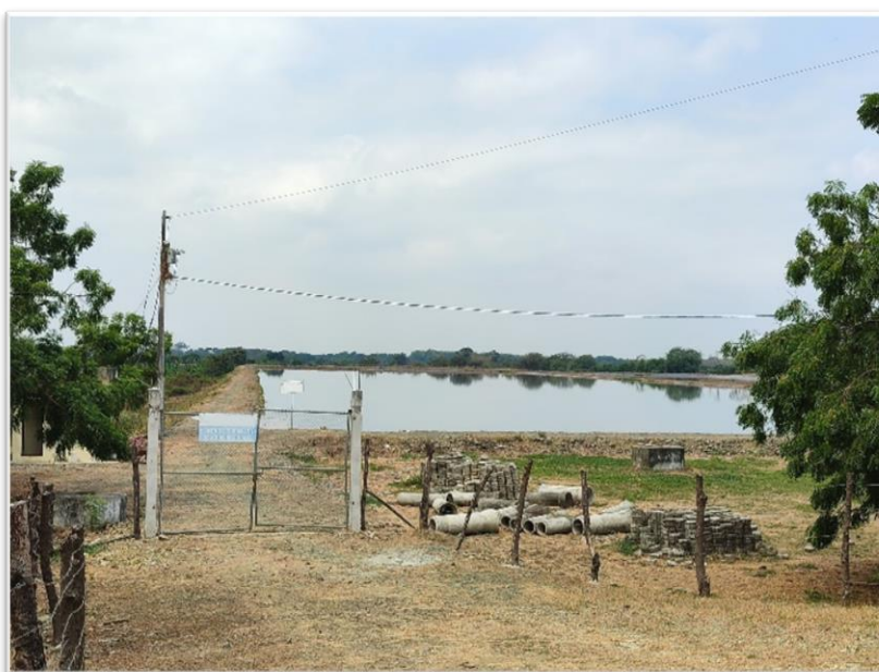
Imagen 47. Laguna de Oxidación
