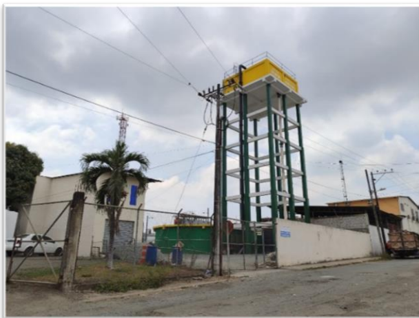
Imagen 45. Tanque elevado - EMAPALS
