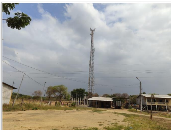
Imagen 32. Antena Claro - Sec. Escobería
