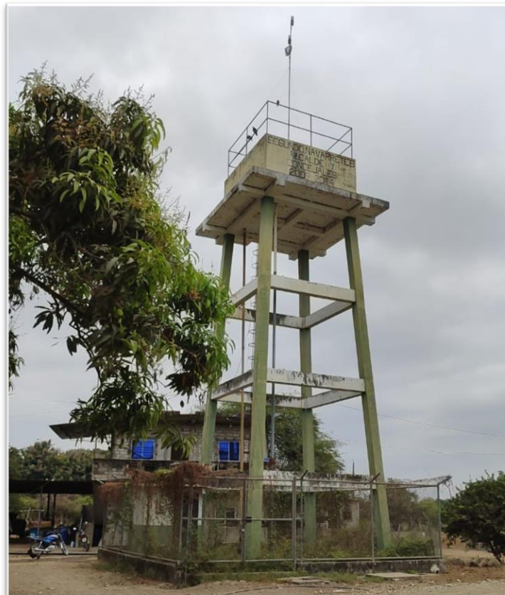
Imagen 46. Tanque elevado – Las Cañas
